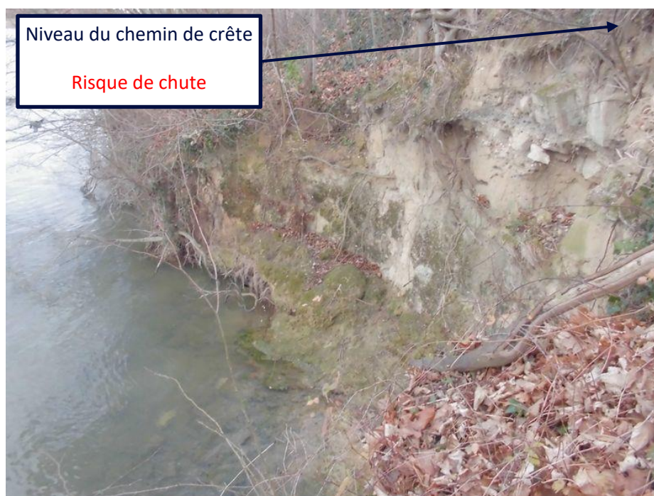
Figure 27 : Dégradation de la berge par le batillage
