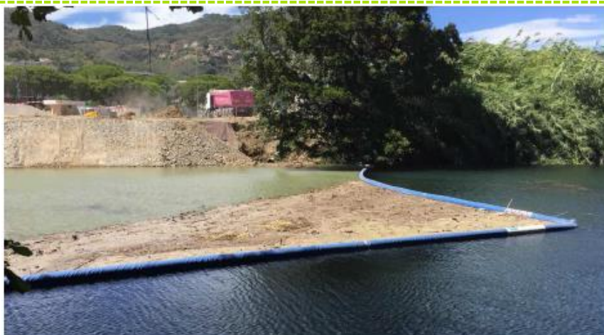
Figure 30 : Exemple d'un filtre anti-MES
